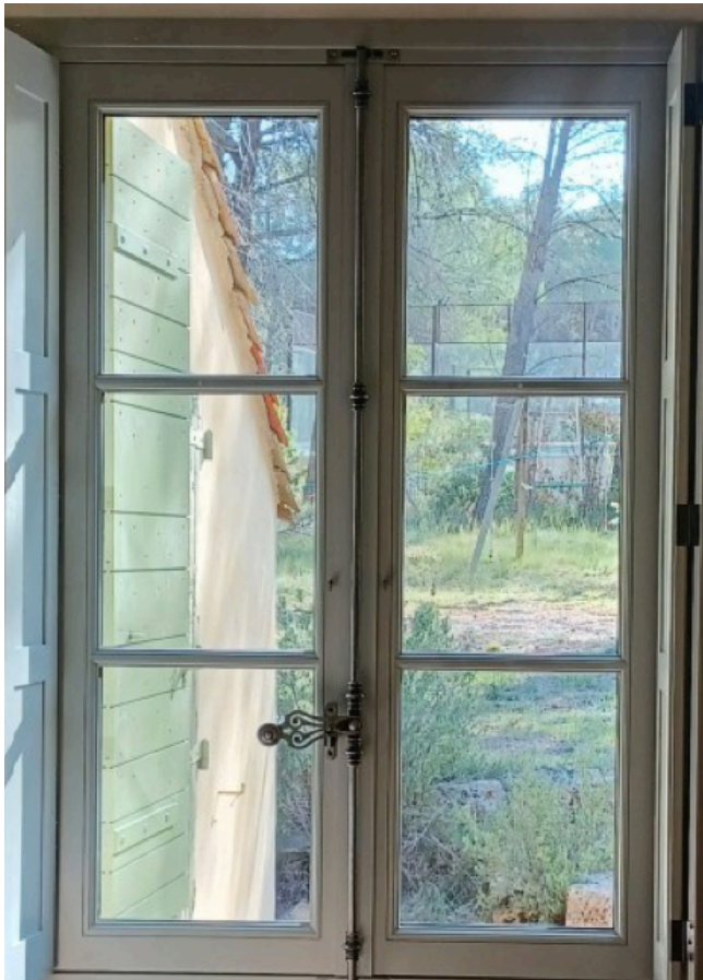
Fenêtres anciennes fines
