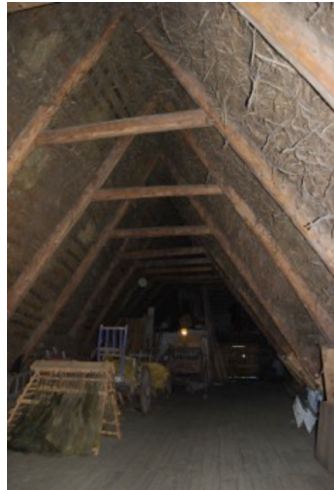
Charpente à 60° pour toit de genêt (Philip)
