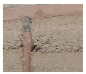
Pour l'opération de projection le mélange chaux chanvre a été légèrement plus mouillé, (un quart de seau en plus) et il a été « projeté » à la main, sur une épaisseur de 2 à 3 centimètres, pour bien adhérer au support.
