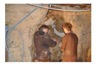
Pour combler les irrégularités du mur un mélange de chaux et de plâtre gros a été utilisé pour éviter les sur épaisseurs du mélange chaux-chanvre.
