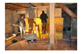
Le week end suivant on a procédé au débanchage et on a pu constater que globalement la régularité de la mise en place était satisfaisante. Seul un coin d'une dizaine de centimètres mal tassé a nécessité une intervention de comblement manuel.
