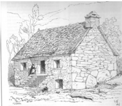
ferme avec foyer mural en pignon
