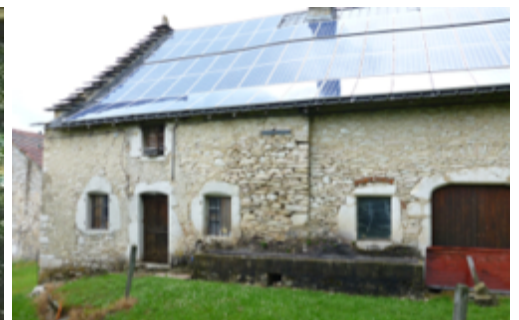
Panneaux solaires dans le Vercors
