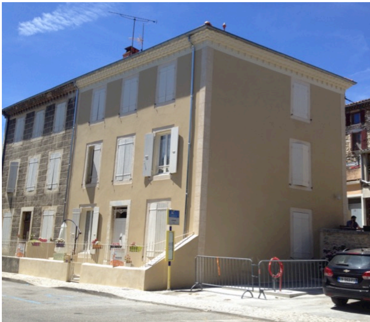
Isolation par l'extérieur avec enduit « Diasen » Photo B leborne
