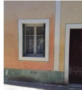
Quand le mur était destiné à être enduit, les pierres n'étaient pas équarries et hourdées avec le même soin que si le travail du maçon devait rester visible. C'est pourquoi lorsque la mode actuelle fait décroître les enduits, l'appareillage des pierres mises à nu se révèle peu soigné et, plus grave, la protection qu'apportait l'enduit disparaît.
