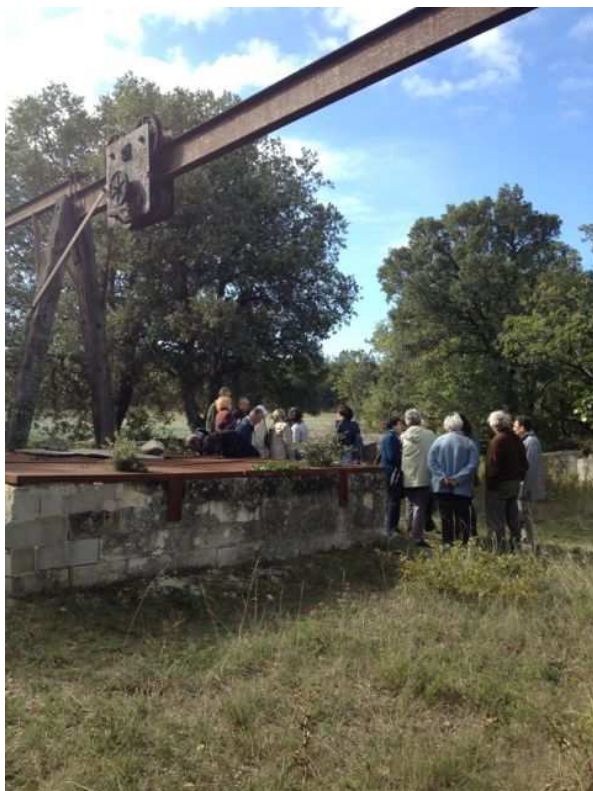
Le puits d'accès, son chevalet et son treuil.
