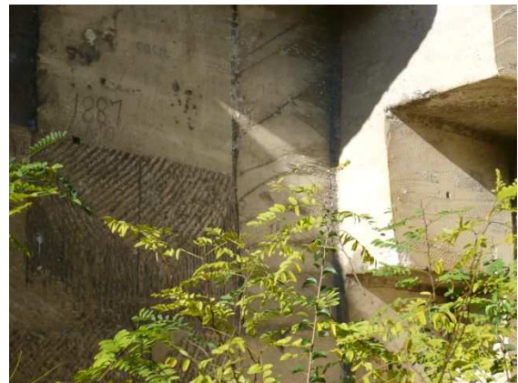
Ci dessus la trace des outils : scies en haut et à droite , pic à pierre en bas.
